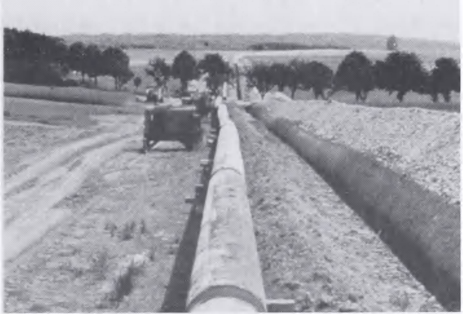
Bau der Ölleitung
